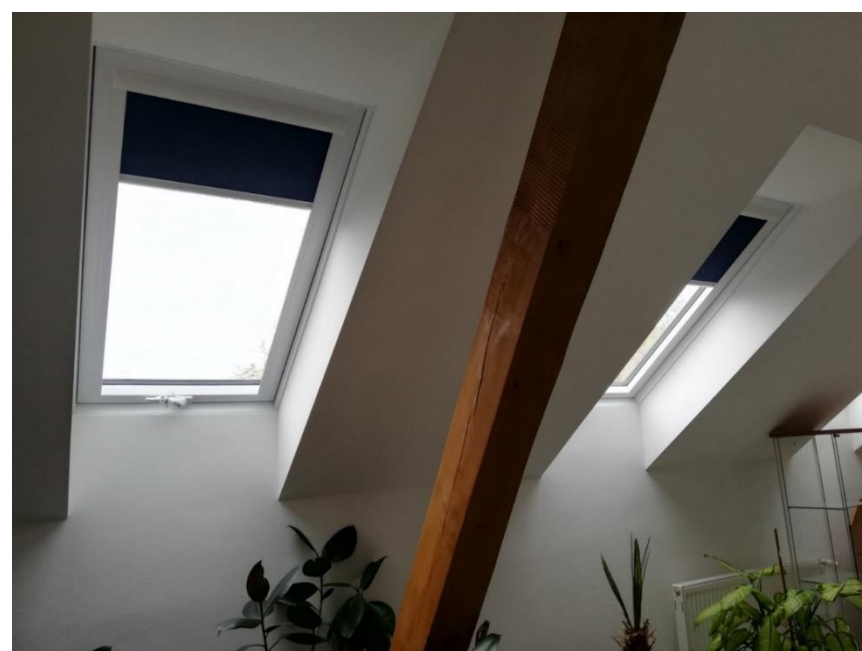
Obrázek 2: okna – po realizaci
